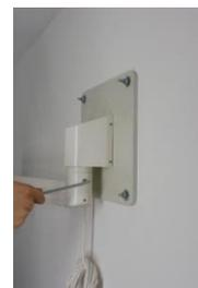
Zum Ausgleich fertigungsbedingter Toleranzen kann es erforderlich sein, den Stecker an der Strahlerkopf-Aufnahme zu justieren. Lösen Sie hierzu die Zylinderkopfschraube in dem Langloch (Schraube **auf keinen Fall** komplett herausdrehen!) (Sechskant-Schraubendreher SW 2,5). Schieben Sie die Zylinderkopfschraube so weit wie möglich in Richtung Strahlerkopf und fixieren sie in dieser Position.
